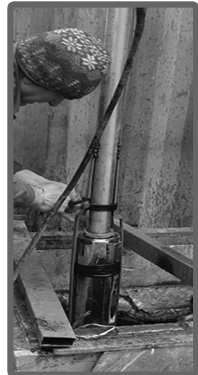
۶- بستن بسط لاستیکی برای نگهداشتن کابل
