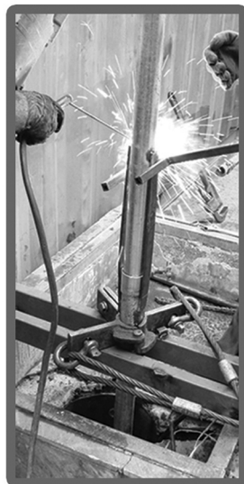
۱۰ - جوشکاری تسمه برای ایمنی بهتر
