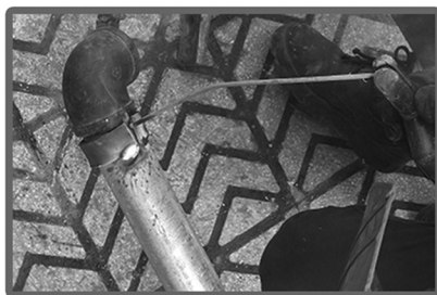
۱۰ - جوشکاری تسمه برای ایمنی بهتر
