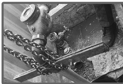
۱۳ - نصب کرپی نگهدارنده پمپ
